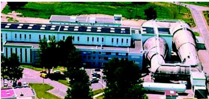
↑ ONERA : la soufflerie F1, à droite, et son bâtiment d'exploitation. ↑
