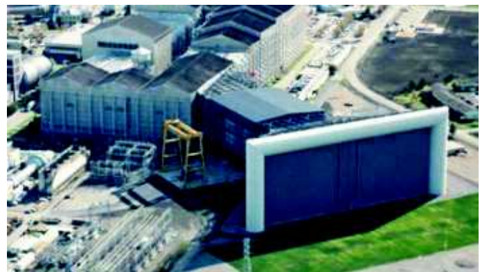
La gigantesque entrée d'air (120 x 40 m) de la soufflerie ouverte de la NASA
